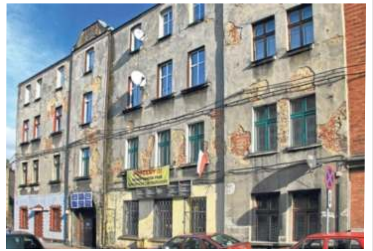
Licytowany budynek przy ul. Barbary 9
